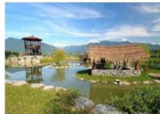
砌石雙心池護岸修復，以生態砌石工法。
